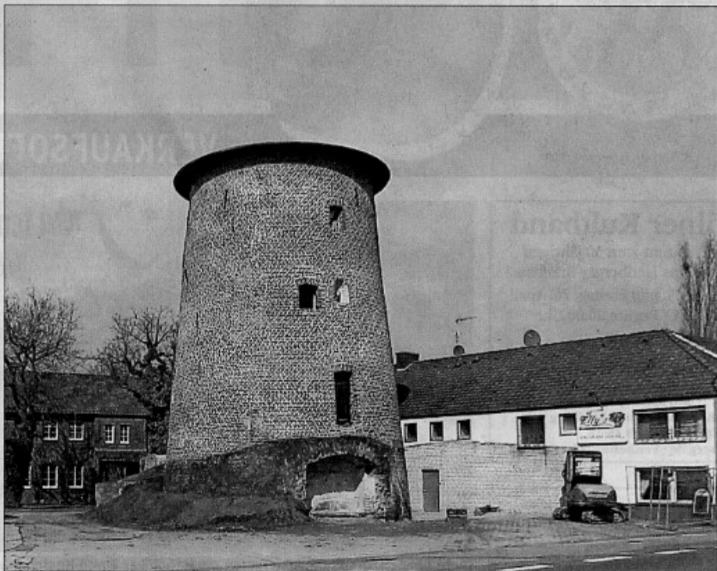
Im zweiten Bauabschnitt wurde der aufgeschüttete Mühlenberg an der Schriefersmühle abgetragen und arrondiert. Foto: Pressestelle Mönchengladbach
